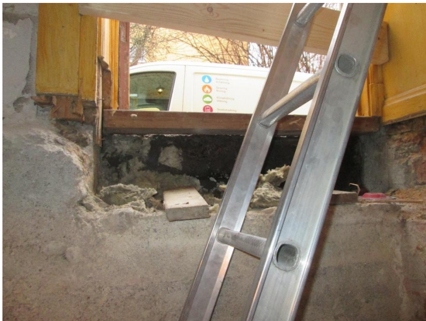
Visar mycelpåväxt på och intill ytterdörr karm.
