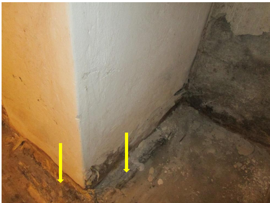
Vägg mellan trappa och källarhall.
