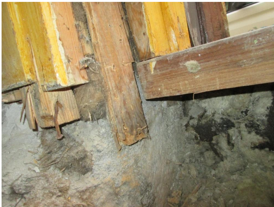
Visar mycelpåväxt på och intill ytterdörr karm.
