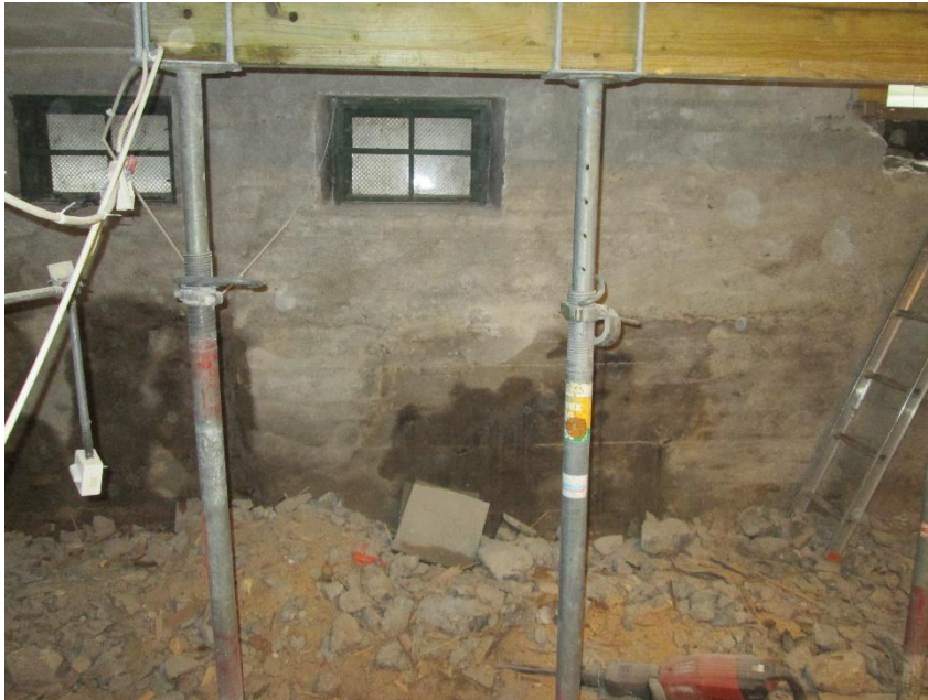
Visar vägg efter man tagit bort puts samt bilat upp golv.
