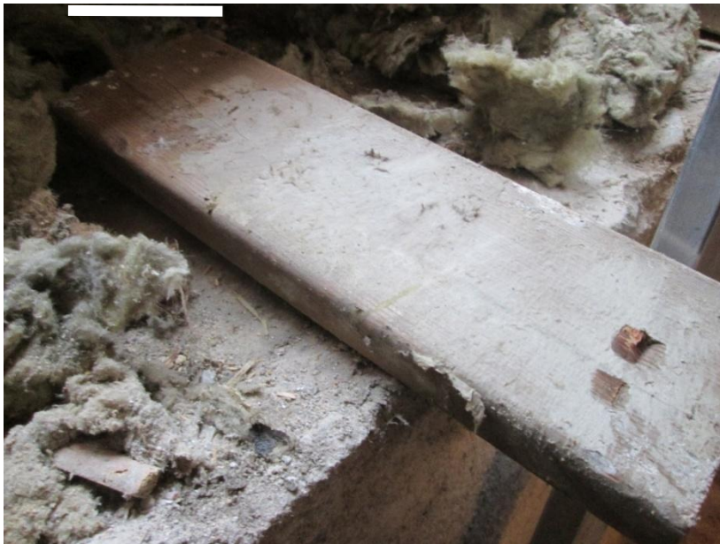
Visar tryck impregnerad bräda med mycelpåväxt som har suttit under tröskel.
