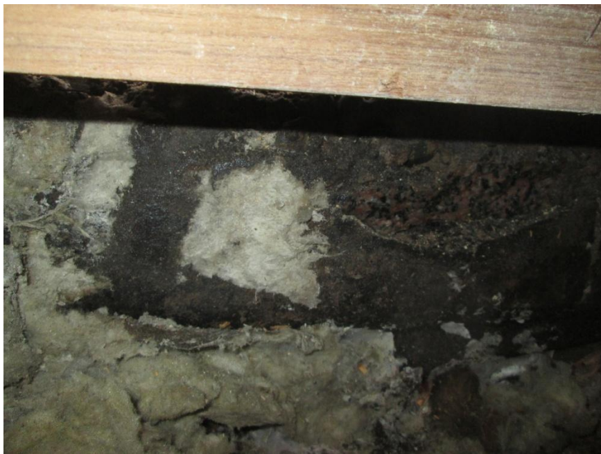
Visar mycelpåväxt på och intill ytterdörr karm.
