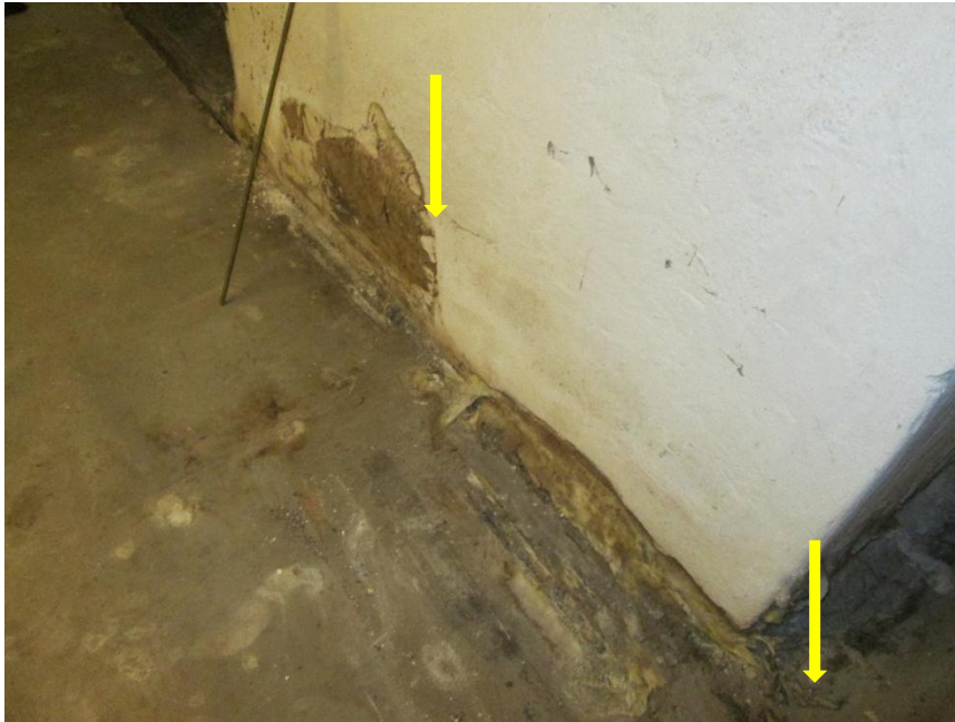
Vägg mellan trappa och källarhall.
