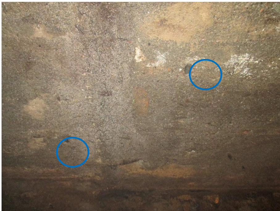
Visar borrvattnings håll där man håller i Boracol i väggen.
