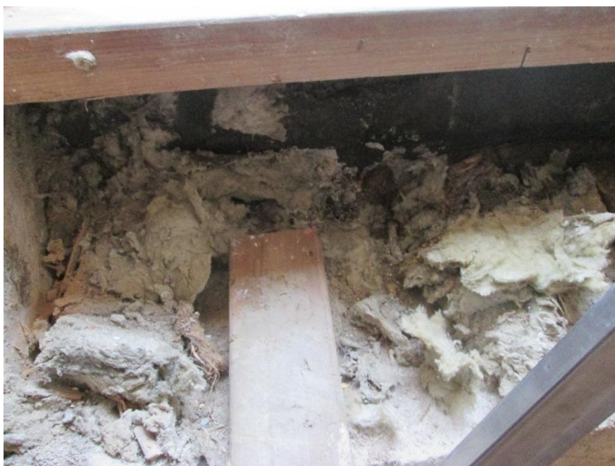
Visar mycelpåväxt på och intill ytterdörr karm.
